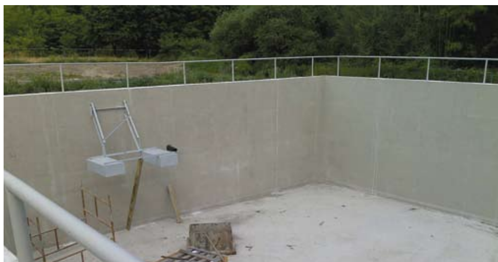
Budowa oczyszczalni w Toporzysku
